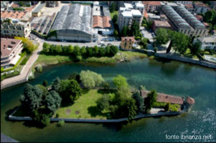
Lunga circa 110 metri e larga al massimo 27, è posta vicina alla sponda orientale del fiume, da cui la separano un minimo di 11 metri; nessun ponte, per quanto breve, la collega alla terraferma.
